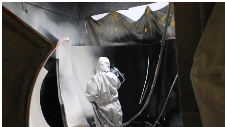
Figura 9: Pintado, línea 1 Fuente: CVNS INDUSTRIAS S.A de C.V
